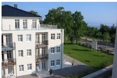
Hausansicht "Villa Aquamarina" von der Südseite (Nachbarhaus)
